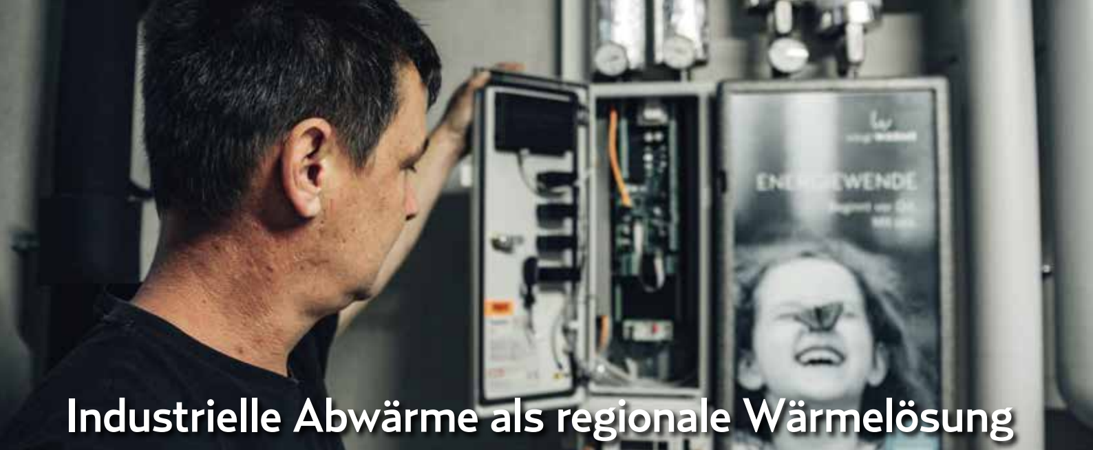
Foto: Stadtwerke Wörgl GmbH
